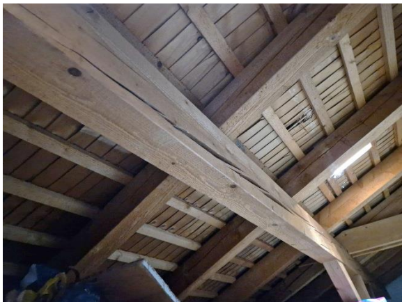
Dachkonstruktion über Erdgeschoss
